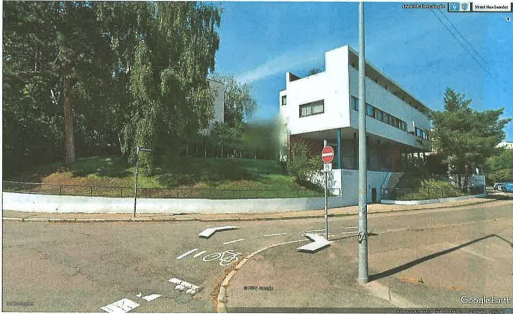
Abb. 6: Hauptblickachse auf die Le Corbusier-Häuser von Südosten (Beginn Rathenaustraße) nach Nordwesten blickend. Die geplanten WEAs sind außerhalb des Sichtbereichs im Westen (Quelle: Google Street View).
